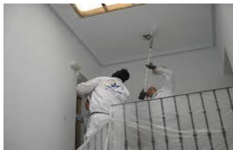
Figura 3. Recubrimiento de porosidades y protección contra humedad en paredes.
