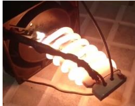
Figura 4 Prueba de funcionamiento de ambos sistemas de forma simultanea
